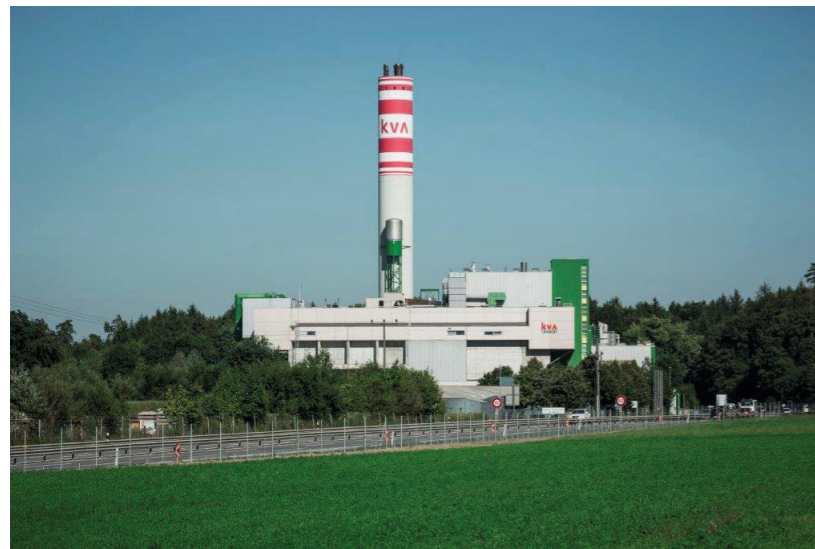
KVA Buchs, Außenansicht
