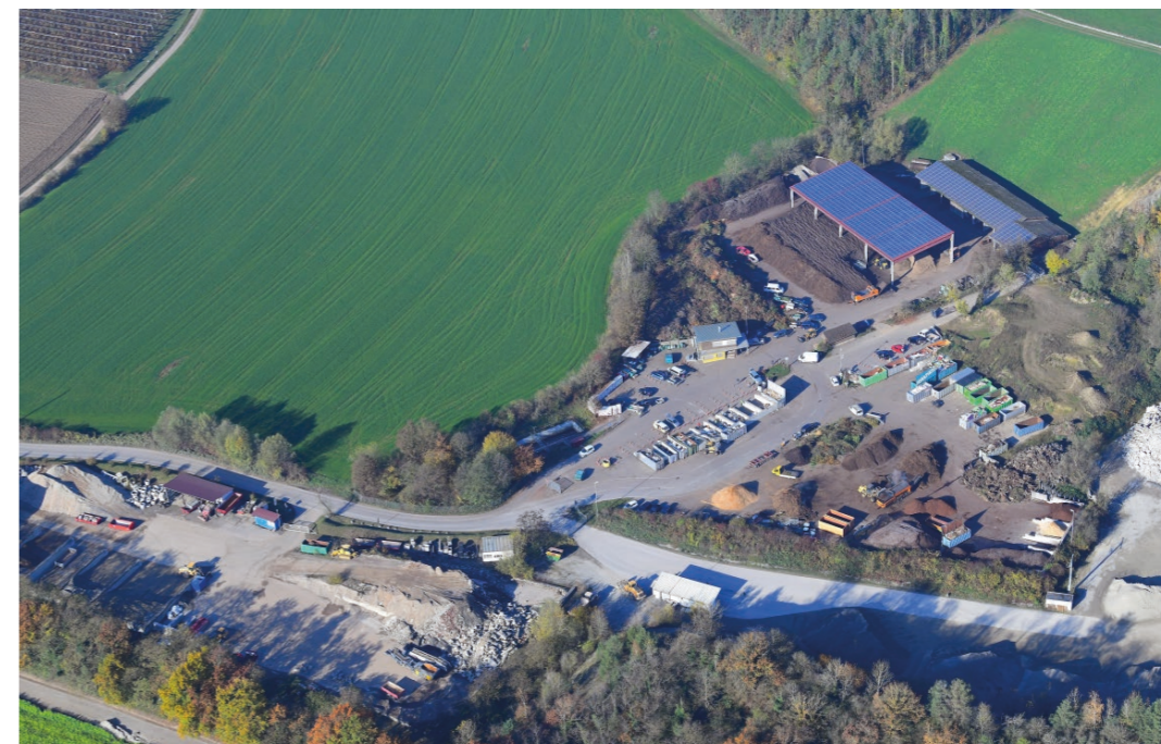
Bild EBA, Grünkompostierungsanlage Küssaberg
