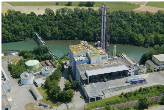
links: KVA Turgi, Außenansicht
