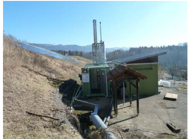
Schwachgasentsorgungsanlage CHC 25, Firma LAMBDA
