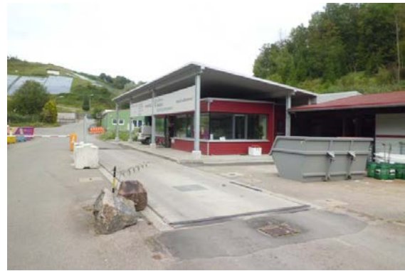
Eingangsbereich der Deponie mit Waage
